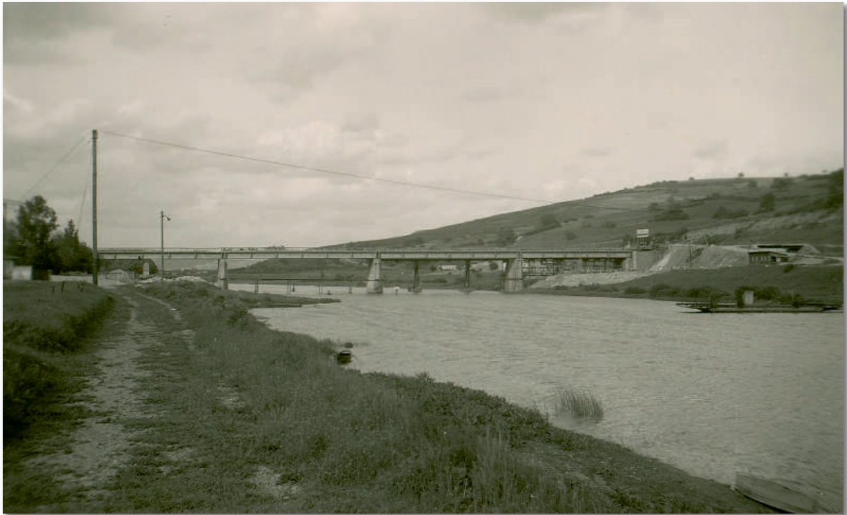
Abbildung 32: Ein historisches Zeitdokument aus dem Jahre 1955 – die neu errichtete Brücke Grevenmacher vor ihrer offiziellen Inbetriebnahme (15.12.1955) – zu sehen ist am rechtem Ufer die Fähre, welche seit dem 1. Februar 1952 in Betrieb war, am linken Ufer ist der Verlauf des einstigen Treidelweges noch gut erkennbar.
