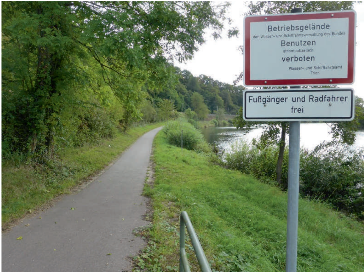
Abbildung 30: Betriebsweg der Wasserstraße Mosel am rechten Moselufer bei km 226,900 – als Rad- und Spazierweg freigegeben.
