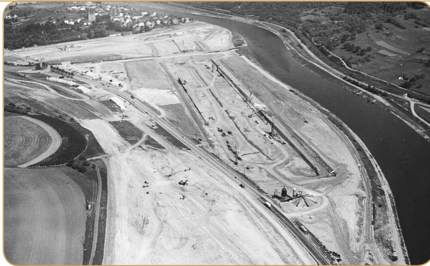
Situation des travaux de terrassement en 1964, au fond on devine le lit de la Syre avant le détournement.
