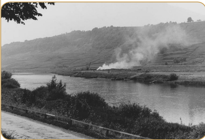
Le site du barrage-écluse de Grevenmacher en 1962, juste avant le début des travaux (les travaux de débroussaillage étant en cours).
