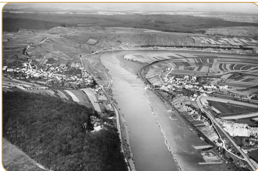
Le site du barrage-écluse de Stadtbredimus avant le début des travaux.
