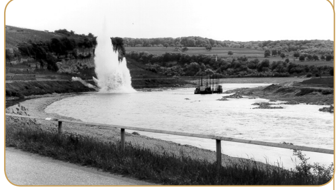
Déroctage à l'explosif d'une barrière rocheuse dans le bief de Grevenmacher (Hüttermühle).
