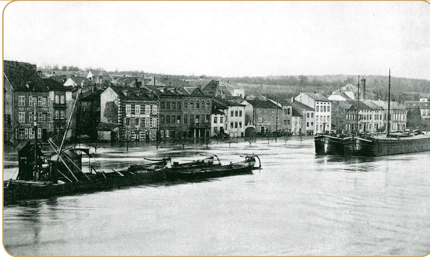
Bateaux immobilisés au quai de Remich lors de la crue de 1910.
