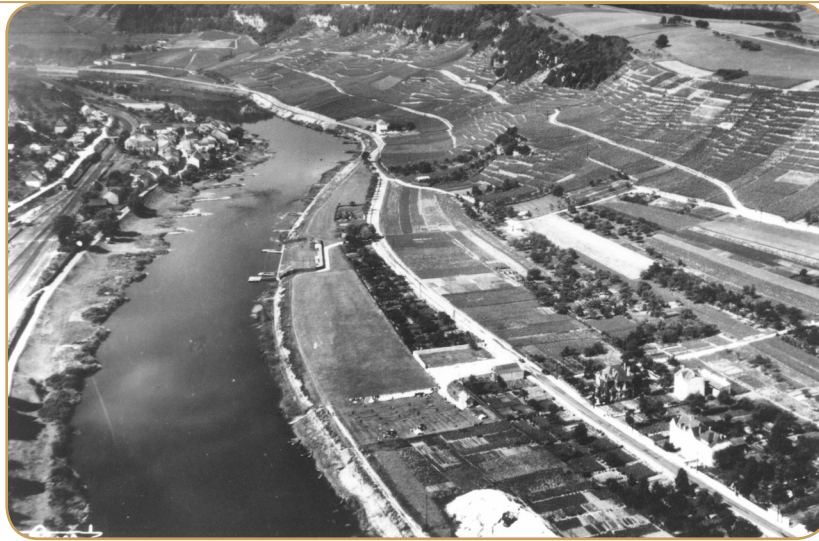
Le site du barrage-écluse de Grevenmacher avant le début des travaux.
