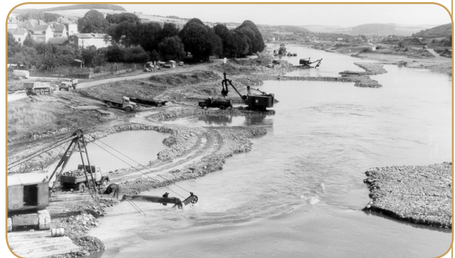
Pelles-preneuses travaillant à partir de la rive ou de digues provisoires.
