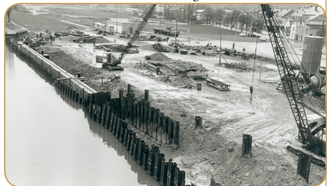
Mise en place d'un écran d'étanchéité et construction d'un quai à Remich.
