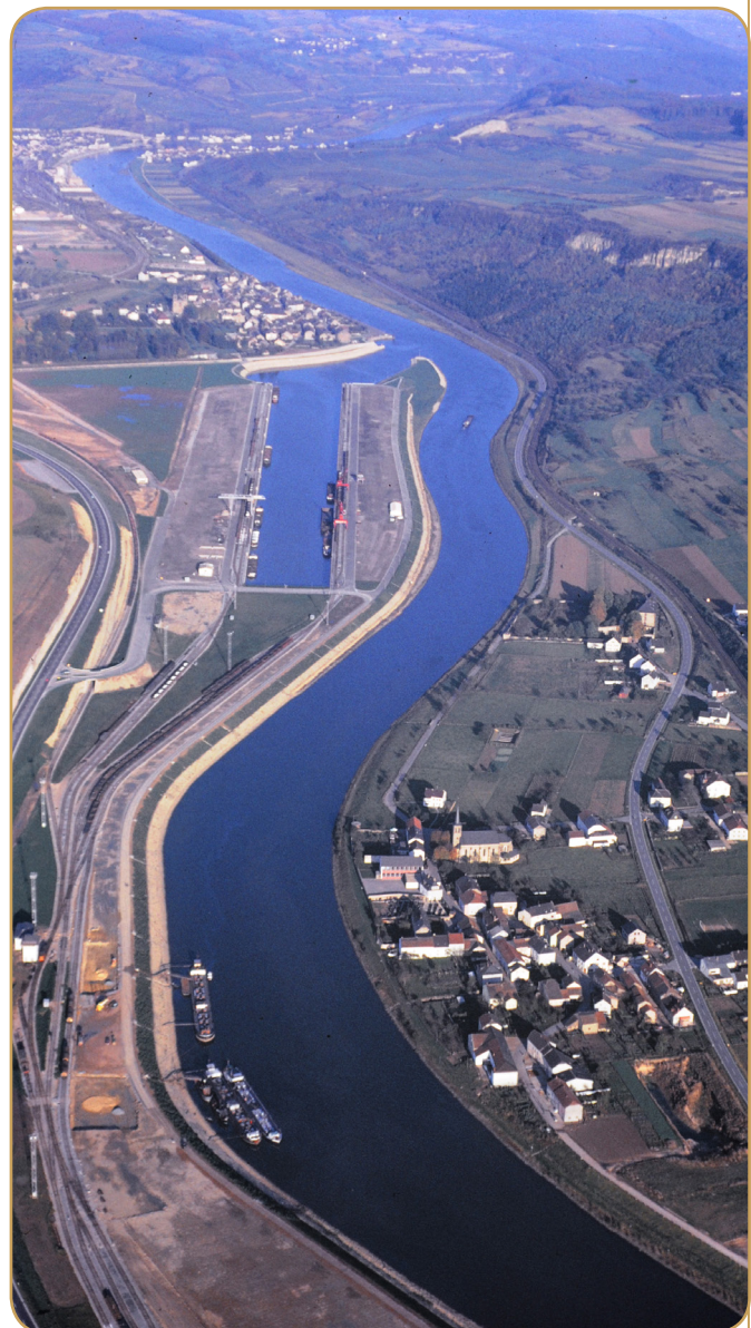
Le complexe portuaire en 1966, la darse est en service, le poste de transbordement pétrolier en cours de construction (rive gauche en bas de l'image).
