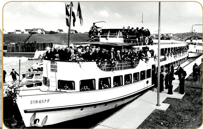
Amarrage au poil près dans l'écluse de Grevenmacher.
