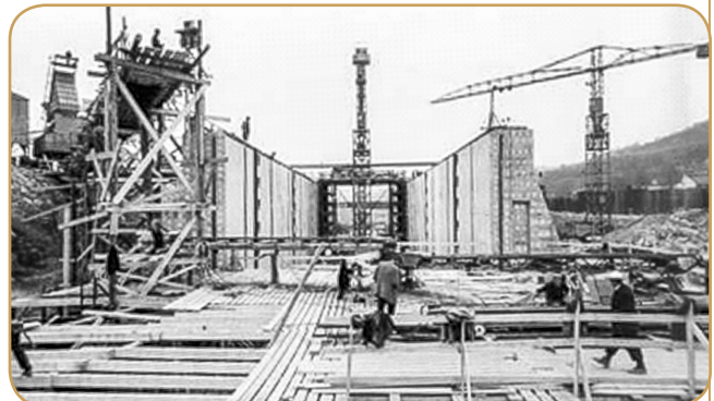
Coffrage des bajoyers de l'écluse.
