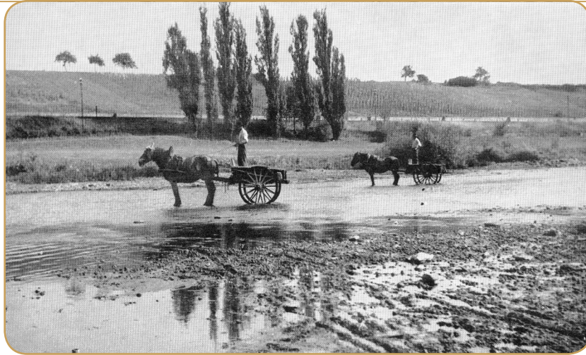
Récupération de gravier du lit de la Moselle pendant un épisode d'étiage.
