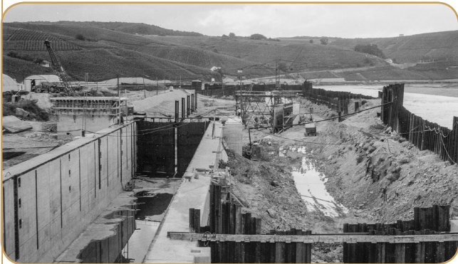
Travaux de gros œuvre du sas d'écluse achevés, le chantier restant asséché par le batardeau.
