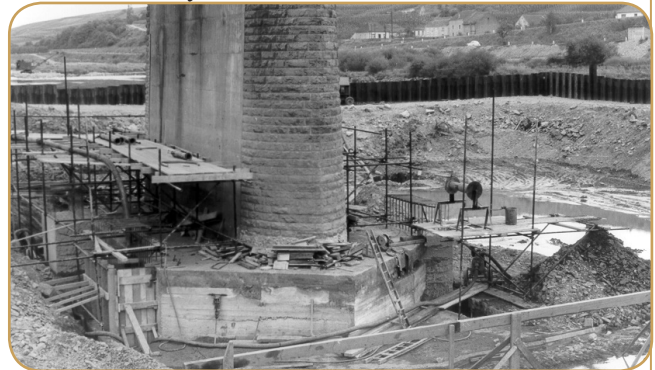
Consolidation des piles du pont de Grevenmacher.
