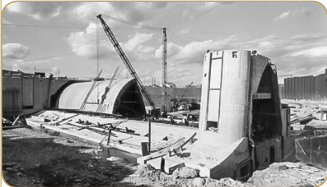
La vanne-secteur gauche du barrage de Grevenmacher en cours de construction.
