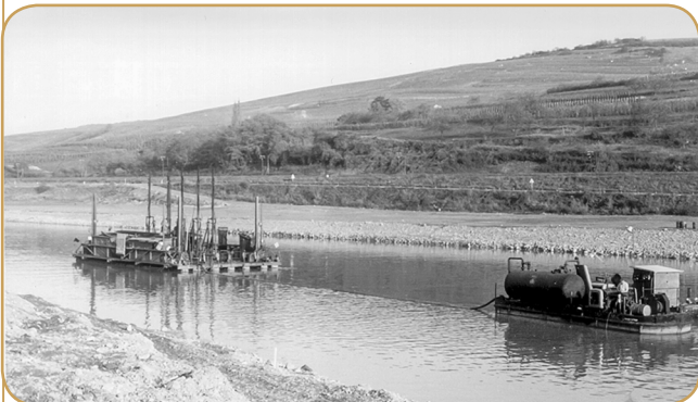
Ponton de forage avec ponton compresseur.
