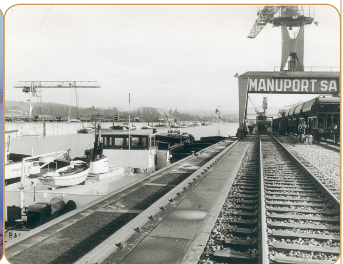
Installations de transbordement du quai sud.
