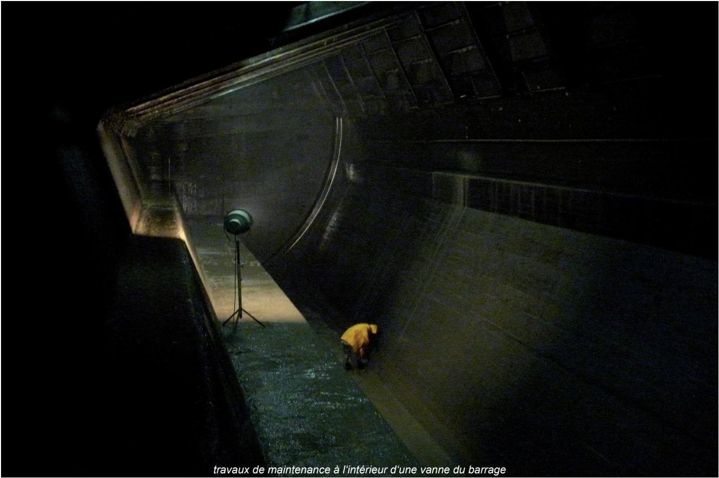
travaux de maintenance à l'intérieur d'une vanne du barrage
