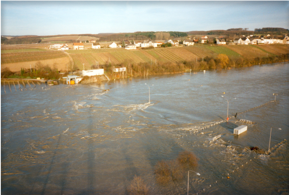
Le barrage-écluse de Stadtbredimus submergé lors d'un épisode de crue majeur
