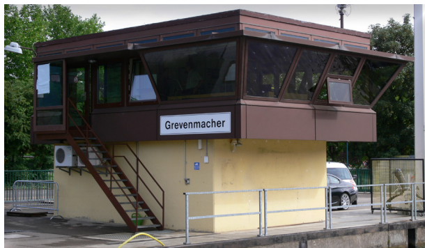
Le poste de commande
