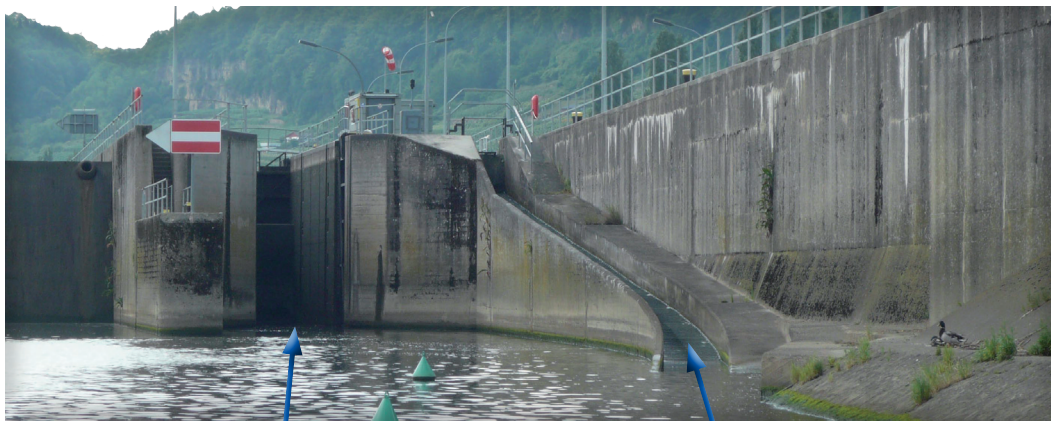
Entrée aval de l'écluse à nacelles
