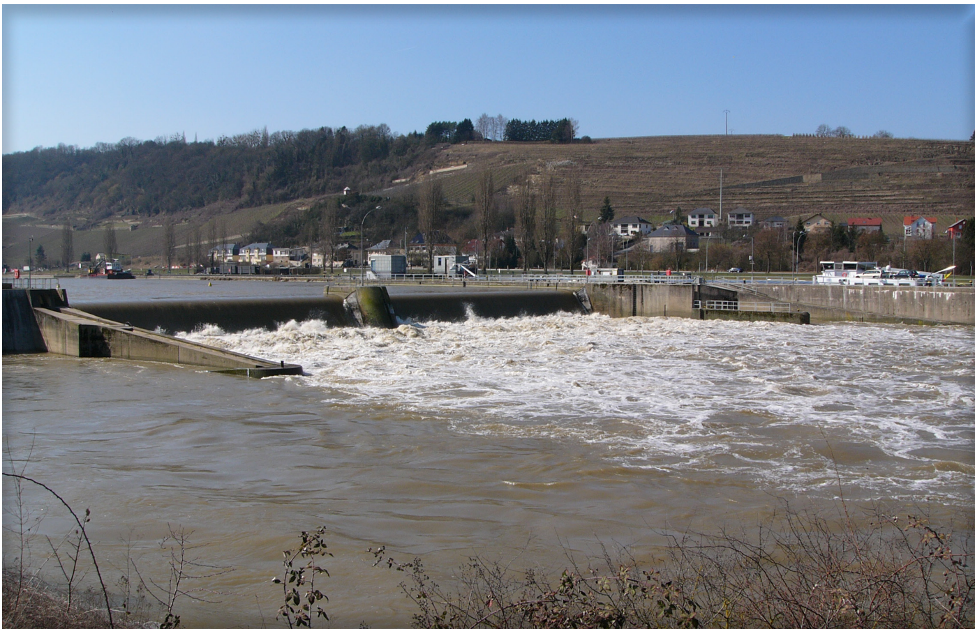
Évacuation du débit d'une crue mineure par le barrage, les deux vannes se trouvant en position semi-abaisée
