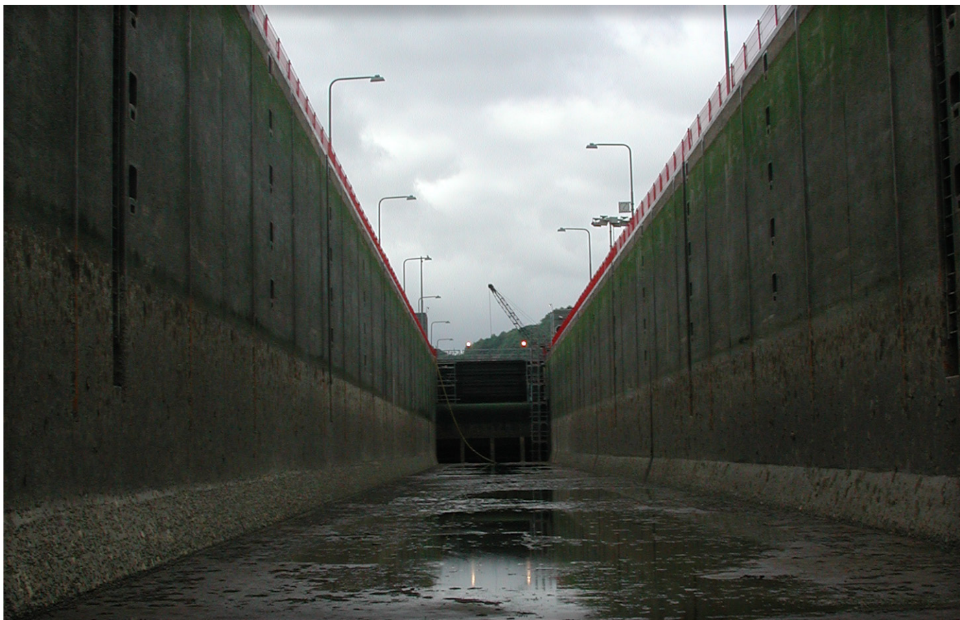
Le sas d'écluse mis à sec pour permettre des travaux de réfection
