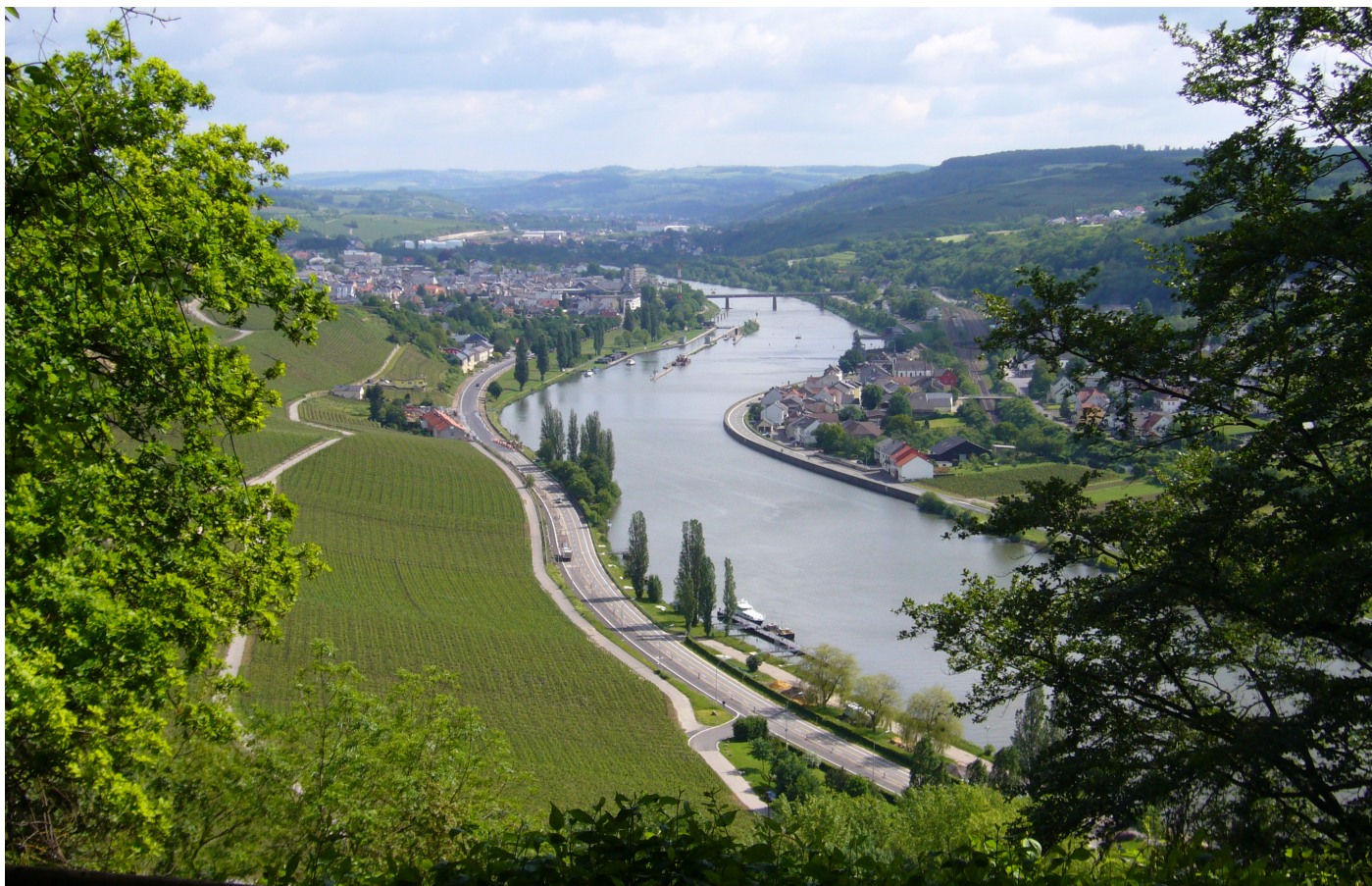
Vue sur Grevenmacher et son barrage-écluse
