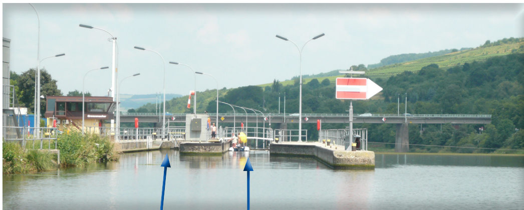
Accès à la rigole pour canoës et kayaks
