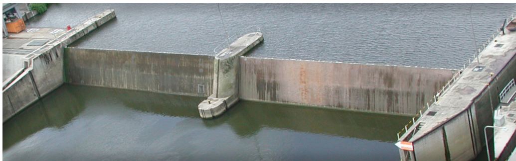
Les deux vannes du barrage de Grevenmacher-Wellen en position fermée
