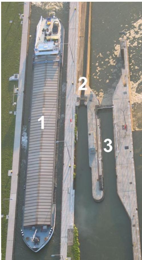
*L'écluse à grand gabarit (1), la rigole pour embarcations de sport (2) et l'écluse à nacelles (3)*
