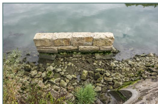
*Muret déflecteur d'un rejet d'eau dont il importe de contrôler l'état fonctionnel et la stabilité d'assise.*
