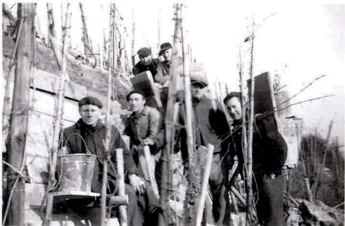
Arbeiter beim Terrassenbau früher
