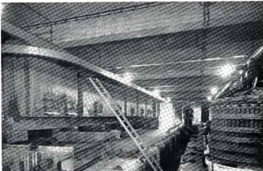
Abmontieren der alten Kelter
