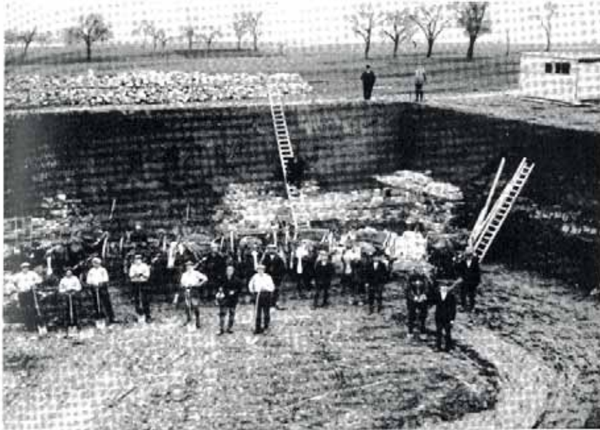
Das Ausschachten der Keller 1929
