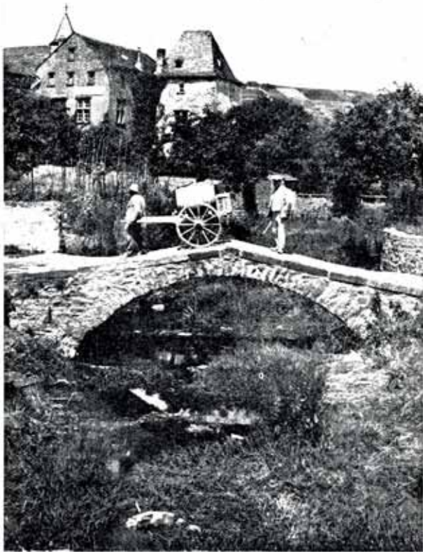
EHNEN: Bachbrücke mit Kasino
