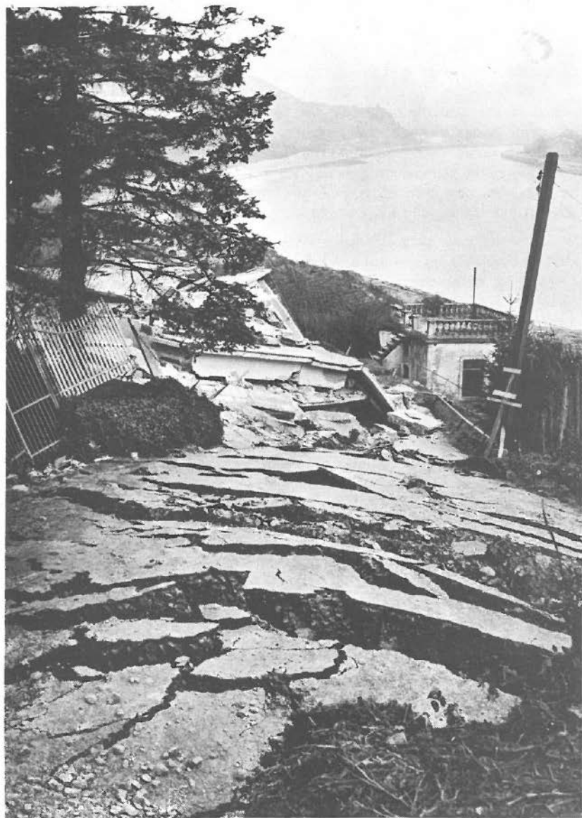
Figur 15 : Rutschung an der Deisermühle im Dezember 1964 (Foto R. STERBA)
