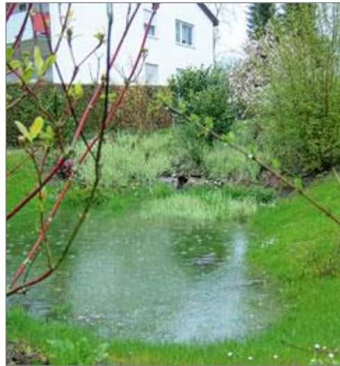
Abb. 9: Gestaltungsbeispiel für eine naturnah gestaltete Retentionsfläche im öffentlichen Grünbereich. Quelle: https://www.dabonline.de/2009/08/01/abfluss-ohne-rohr/
