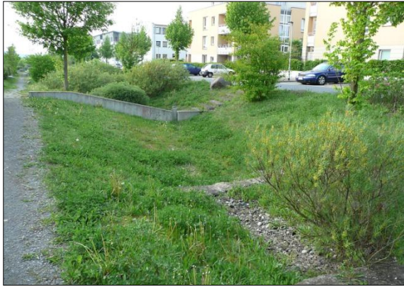
Abb.9: Mulden-Rigolen-System in der EXPO-Siedlung am Kronberg in Hannover, Quelle: M. Manske, Mai 2009.
