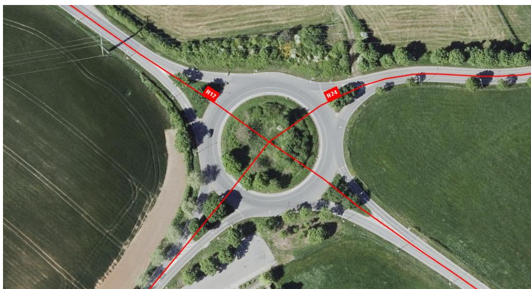
Figure 3 : Le giratoire situé au nord de Rippweiler.
