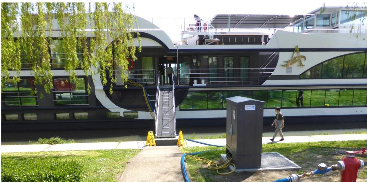
Borne de raccordement électrique haute puissance triphasée Powerlock 400V / 400A pour bateaux hôtels.
