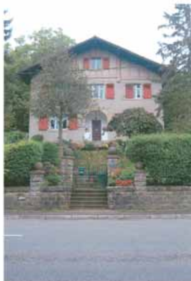
Maison de "style Suisse" des années 1930 à Bollendorf-Pont
