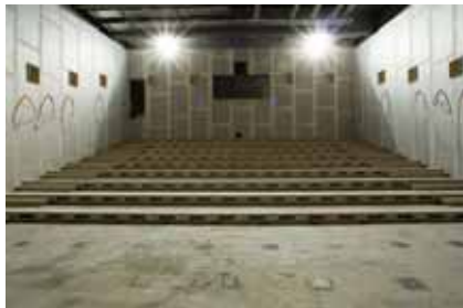
Chantier du nouveau CNA, CinéStarlight II © Romain Girtgen, CNA
