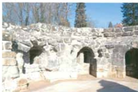
Château de Beaufort - Etage supérieur de la tour nord-est avec le nouveau dallage en place
