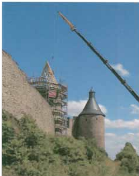
Château de Bourscheid – Montage de la nouvelle charpente
