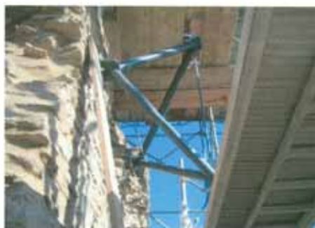
Château de Brandenbourg - Structure métallique de stabilisation en cours de montage
