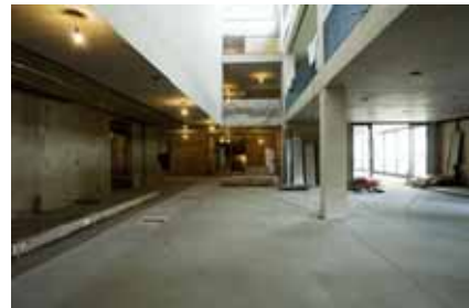
Chantier du nouveau CNA, Hall d'entrée © Romain Girtgen, CNA
