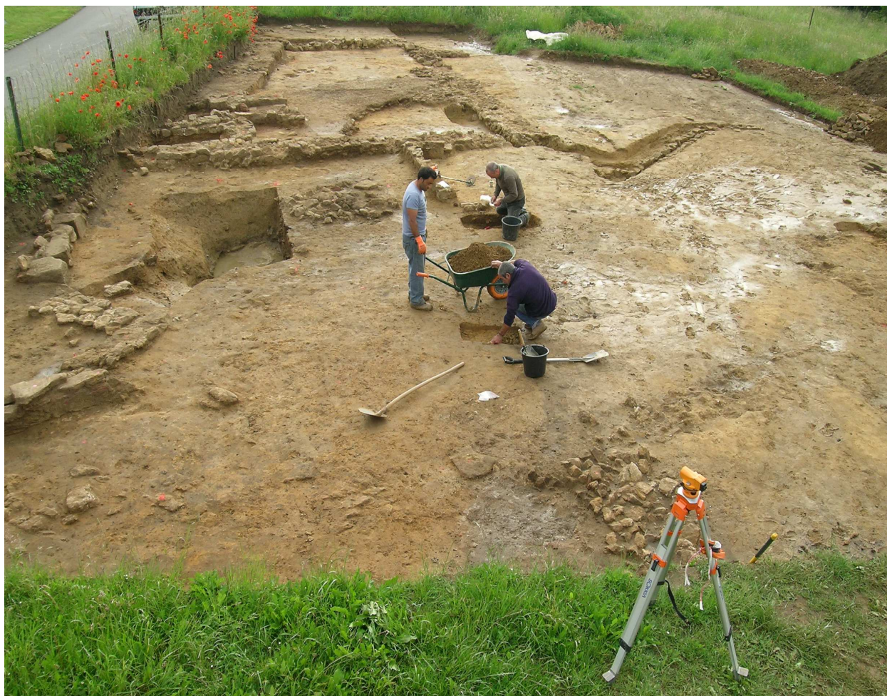
Altrier-« auf Oiselt » : Fouille d'urgence menée par le CNRA au printemps 2012 sur le site d'un nouveau lotissement résidentiel. Ces recherches ont permis de mettre au jour et de documenter - avant destruction – une nouvelle partie des substructions de l'agglomération romaine d'Altrier. (photo CNRA)
