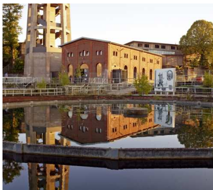
Salle des pompes
