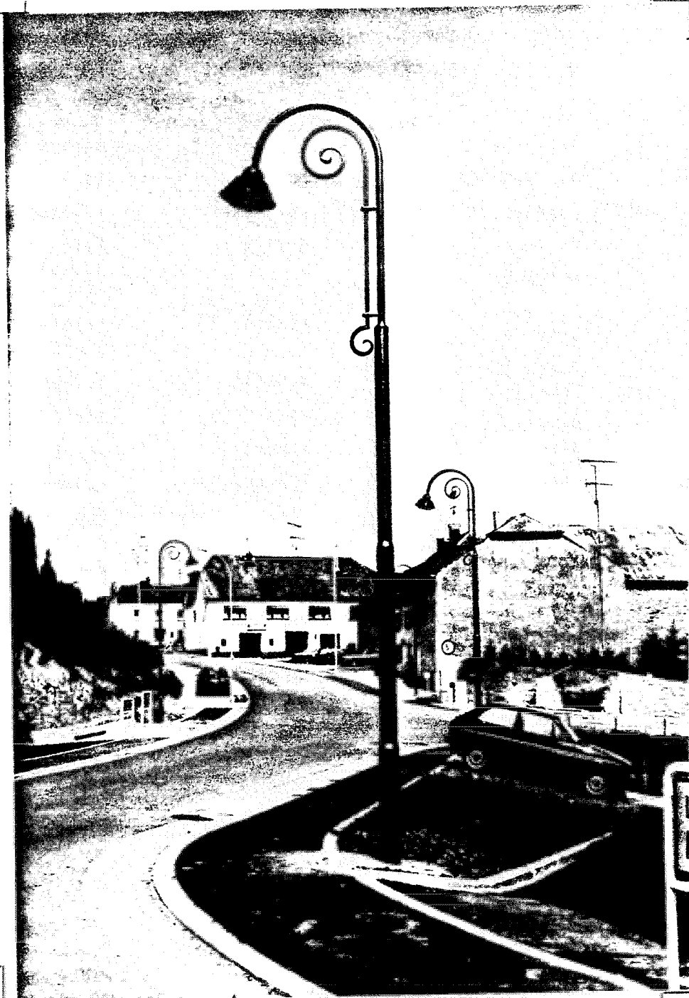
CANDELABRE 8 ( type ENTREE-VILLAGE ) couleur DB 703 (gris mét.) Armature VULKAN 3508 couleur RAL 7016 (Anthrazit) localité: SCHOUWEILER
