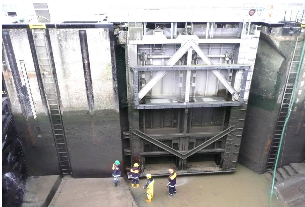
Inspection et réparation du palier sous-marin du vantail droit de la porte aval de l'écluse de Stadtbredimus
